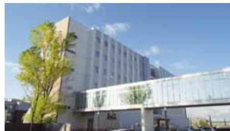
北大内にある次世代ポストゲノム棟
